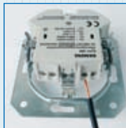
Установленный модуль защиты от перенапряжения
